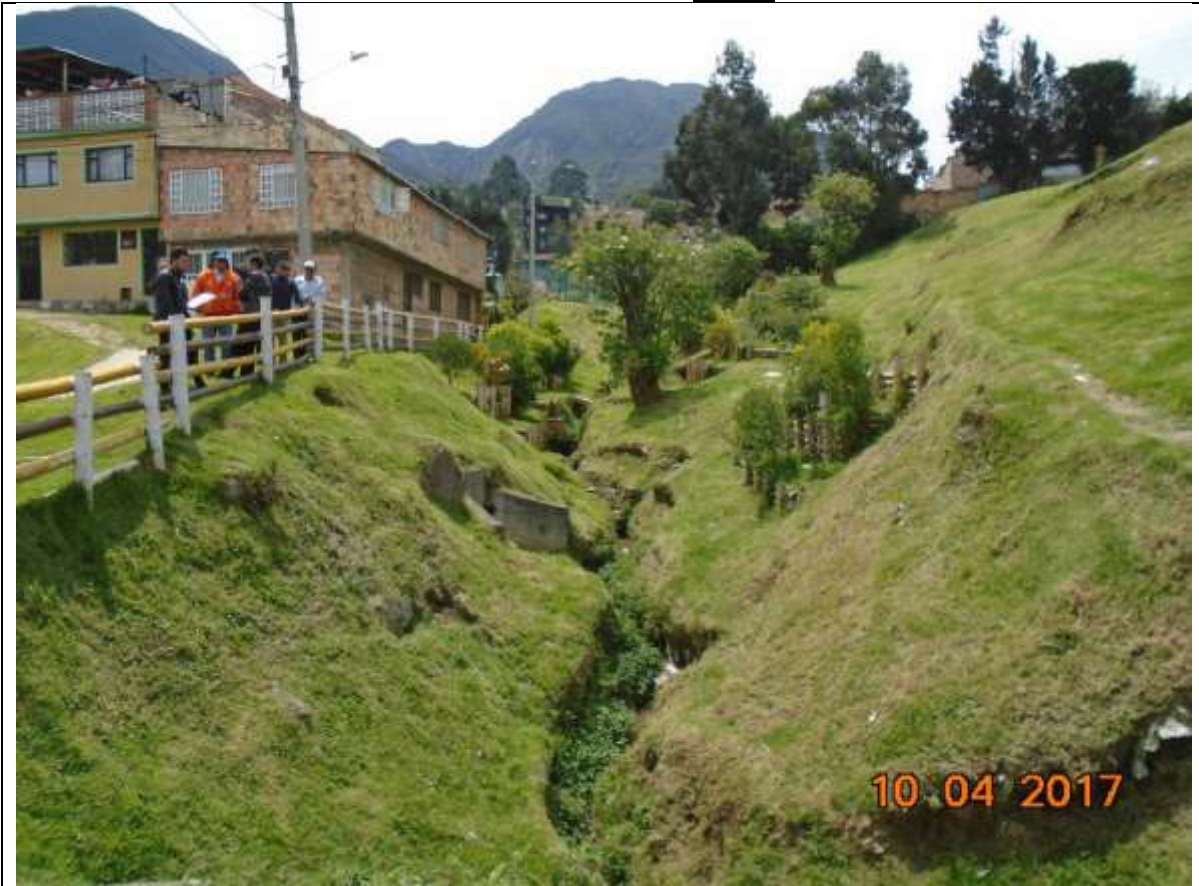
Fotografía 5. Aunque no es un punto de intervención del box coulvert, esta imagen no muestra una parte de las características del entorno físico general de la zona y el cauce.
